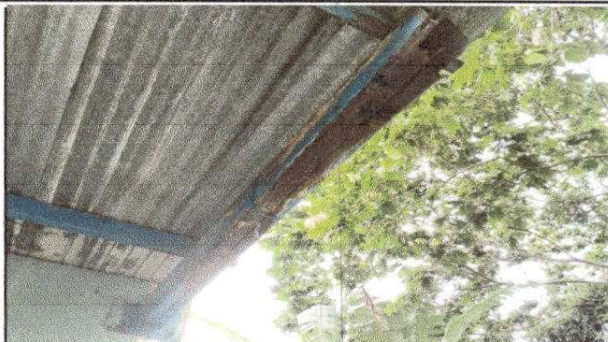
FOTO 2: Sustrución de estructura de soporte de metal, por metal
