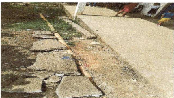
FOTO 5: Reparación de banquetas de concreto
