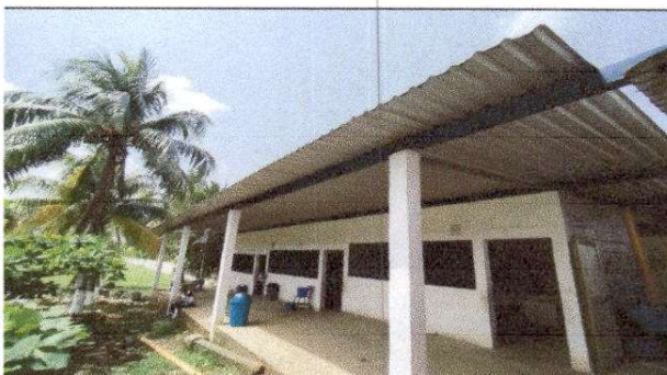
FOTO 4: Sustrución de canal de metal
