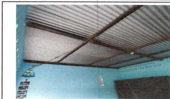
FOTO 8: Instalación de unidades luz (incluye interruptor, ducto y cable eléctrico)
