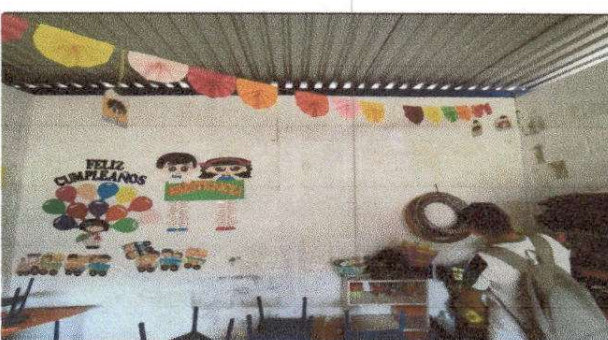
FOTO 6: Pintura en muros exteriores e interiores
