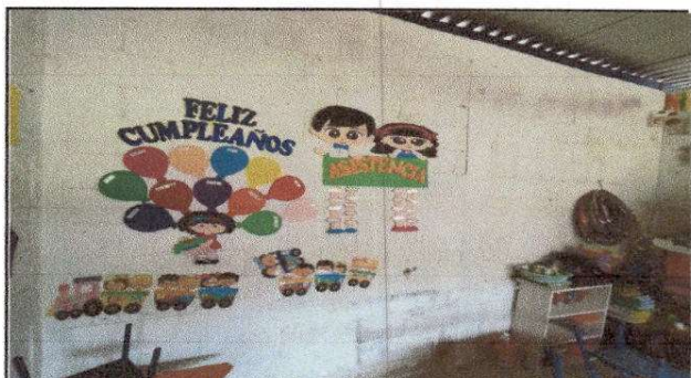
FOTO 10: Repello en muro
