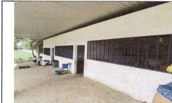
FOTO 7: Fabricación e instalación de balcones de hierro en ventana
